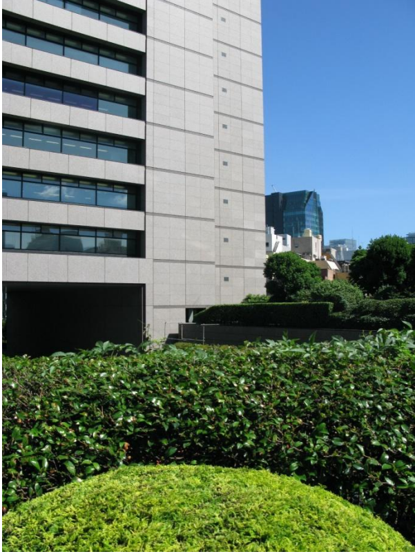
ภาพที่ 17 สวนบนดาดฟ้าอาคารบริษัทประกันภัยมิตซูซุมิโตโมะ
