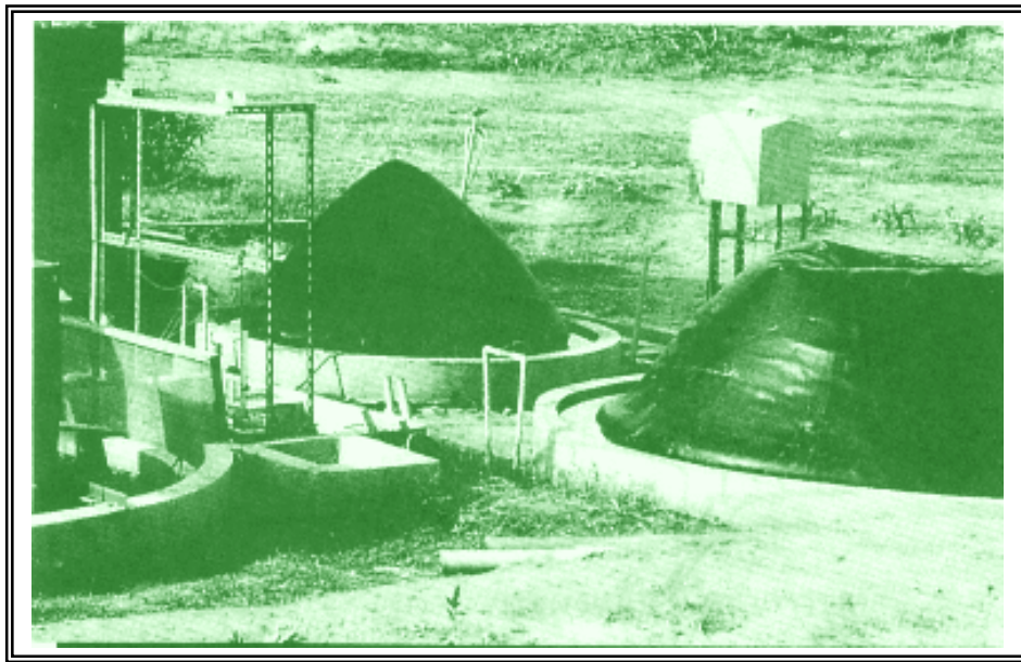
รูปที่ 5 บ่อหมักแบบ AF และแบบ UASB
